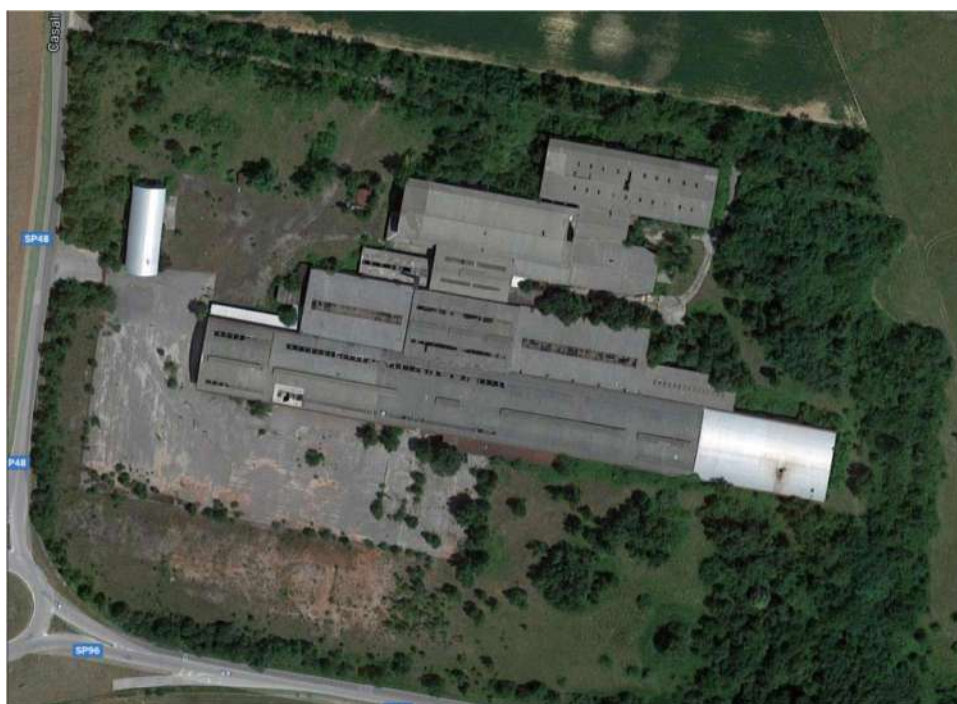
Figura 3: Vista aerea dell'area con evidenza di tutti i fabbricati interessati dalle demolizioni
